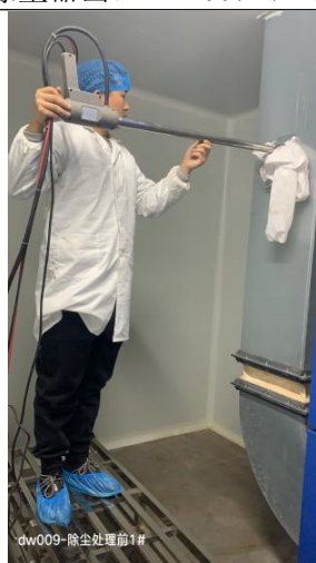
除尘器进口 DW009 (1#)
