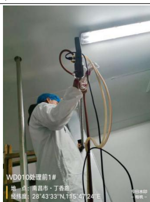
除尘器进口 DW0010 (1#)
