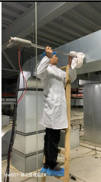
除尘器出口 DW007 (2#)
