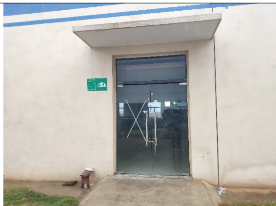
一般固废暂存间
