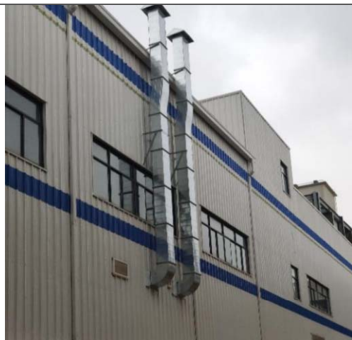
挑选、筛分、破碎粉尘排放口 (18.5m 高排气筒)
