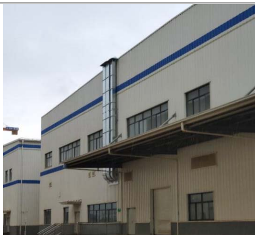
挑选、筛分、破碎粉尘排放口 (18.5m 高排气筒)
