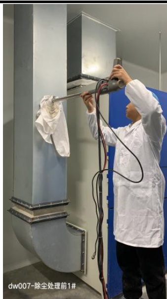
除尘器进口 DW007 (1#)
