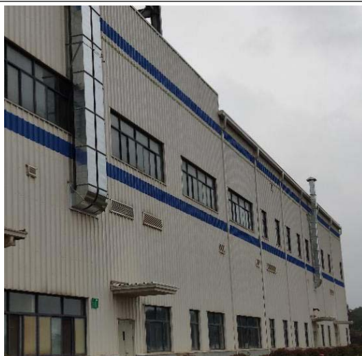
挑选、筛分、破碎粉尘排放口 (18.5m 高排气筒)
